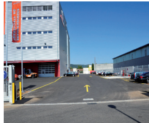
Diese Ansicht bietet sich allen Besuchern und Chauffeuren.
