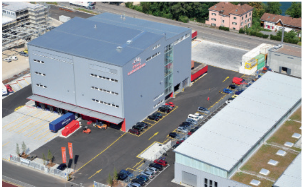
Die Südost-Ansicht des neuen, sechsstöckigen Logistikcenters in Pratteln.
